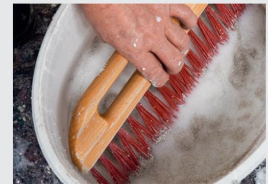
**Profi-Tipp:** Das Werkzeug vor dem Durchkämmen anfeuchten und nach jedem Absatz kurz mit Wasser reinigen. Um eine gerade Struktur zu erzielen, ist es empfehlenswert, stets die äußere Besenkante im Blick zu behalten. Das Werkzeug sollte in einem 45° Grad Winkel zur Wand gehalten werden.
